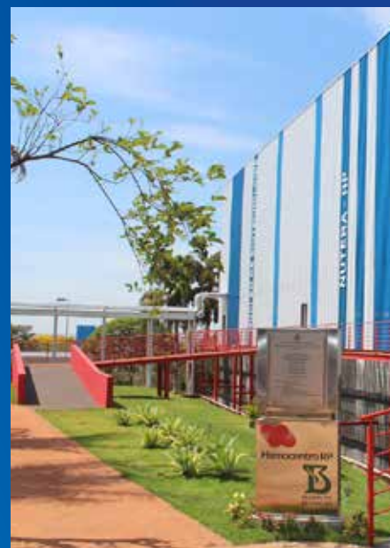
Obra: Núcleo de Terapia Celular Avançada de Ribeirão Preto - (Nutera RP) - R.Preto/SP Instalador: Climapress Tecnologia em Sistemas de Ar-Condicionado Ltda
