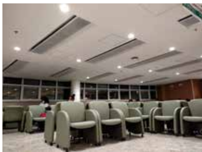
Vigas frias para o conforto interno
