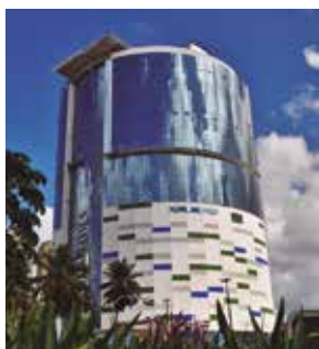
Obra: Hospital Mater Dei Salvador Instalador: Jam Engenharia
