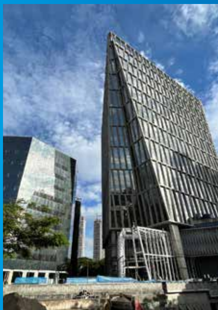
Obra: Luna Crescente - São Paulo/SP Instalador: Best Clima Engenharia e Instalações Ltda.
