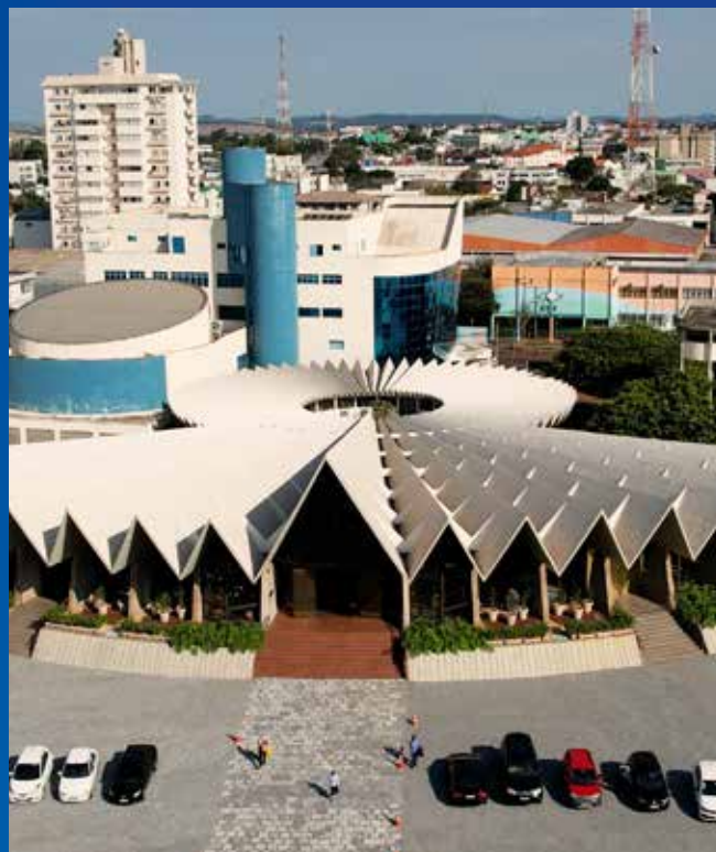
Obra: Catedral - Paróquia Nossa Senhora Aparecida Catedral de Cascavel/PR Instalador: OPJ Construção Empreendimento Ltda
