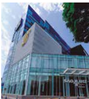
Obra: Hospital e Maternidade São Luiz Osaco Instalador: Star Center
