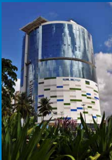
Obra: Hospital e Centro Médico Mater Dei Salvador - Salvador/BA Instalador: JAM Engenharia S.A.
