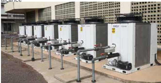
Chillers inverter modulares com condensação a ar
