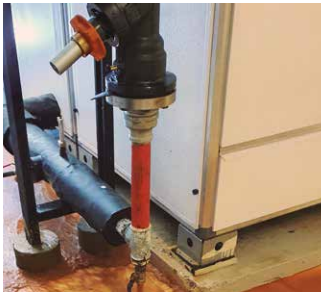
Figura 10. Registro da água que circula no sistema (realizado durante a obra - julho/2021)
