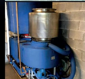
AIR CLEANER In Line a Depuração tecnológica do Ar por extração de poluentes por processo de Filtragem Líquida com performance constante. Vazão de 1.500-45.000 m³/h
