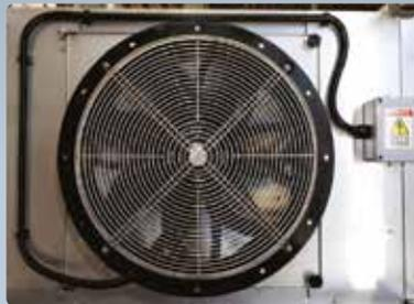
Caixa de passagem e eletrodutos IP66 de acordo com NBR 5410. Grade de proteção do ventilador em inox.
