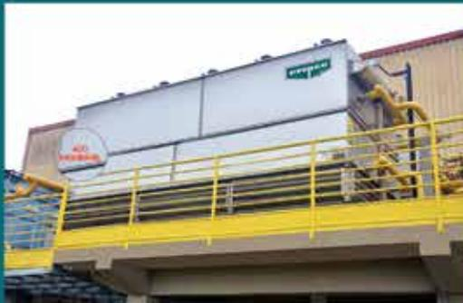
**Condensador Evaporativo 100% em aço inoxidável ou aço galvanizado** - Opcionais: pintura especial para ambientes agressivos, motores AC e EC, entre outros.
